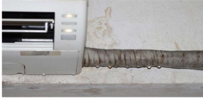
**Gambar 2.3:** AC yang mengalami kebocoran (99.co).
